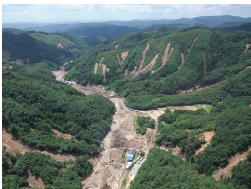
図 2 多数の崩壊と崩土の流動があったことを示す状況
