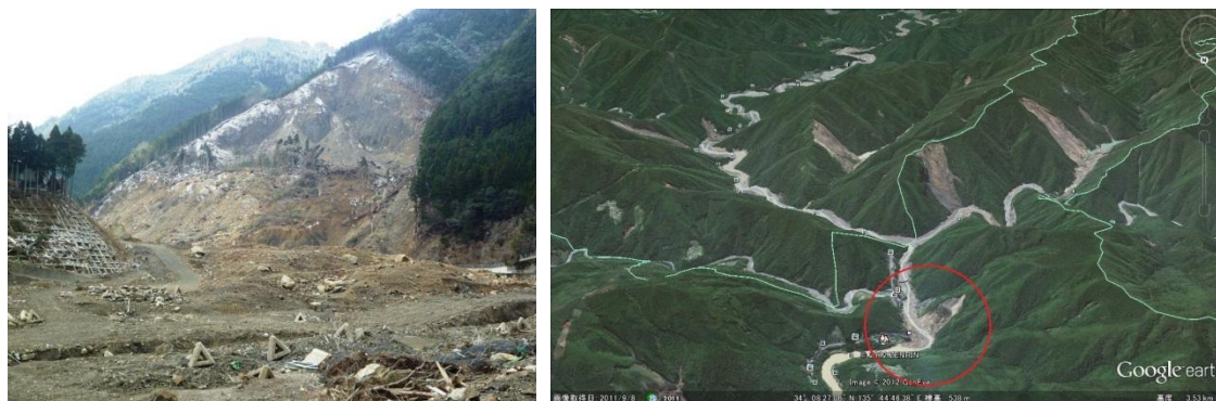
図3 天川上流側から撮影（左）、Google earth から見た崩壊地（右）
