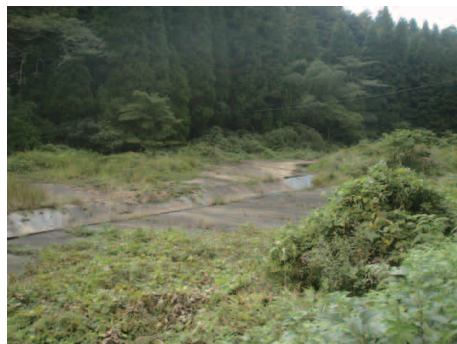
写真2：鉱害対策事業でコンクリートに覆われた笹ヶ谷川
