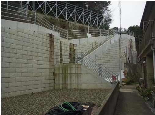
写真-12 民家背後の避難経路
