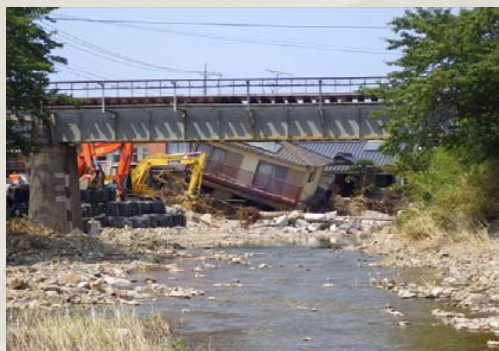
川の氾濫による家屋の倒壊
