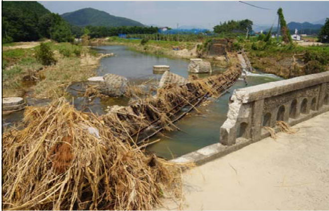
川の氾濫により鉄道橋脚が流される
