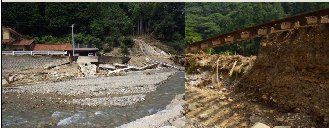
河岸洗掘による道路の一部崩壊
