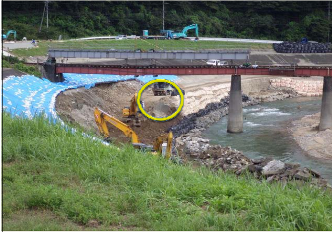
濁川の氾濫により橋桁を破壊
