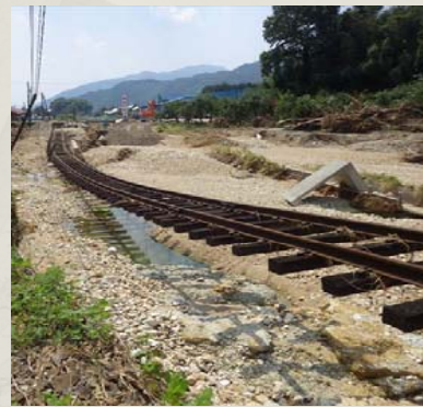
洗掘により線路の盛土が流される
