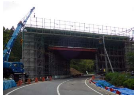
【三隅跨道橋を望む】 ○三隅跨道橋 施工中
