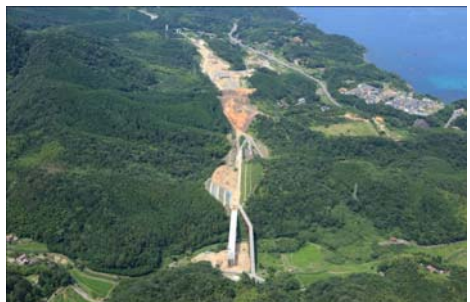
【西村IC(仮称)付近 整備状況】 ○青川橋 完成
