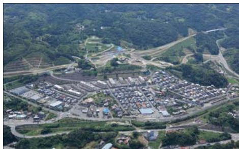
【熱田IC(仮称)付近整備状況】 ○熱田高架橋 完成
