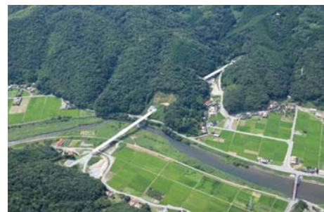
【周布川大橋~吉地高架橋 整備状況】 ○周布川大橋・吉地高架橋 完成
