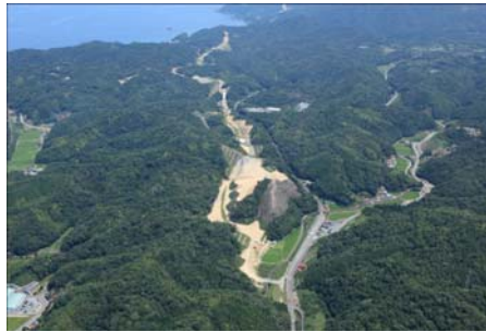
【三隅IC付近 整備状況】
