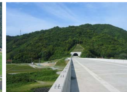
【周布川大橋から塚ヶ原山トンネルを望む】 ○塚ヶ原山トンネル 完成
