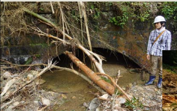
トンネル出口付近の斜面上面からの土砂によりトンネルが埋没
