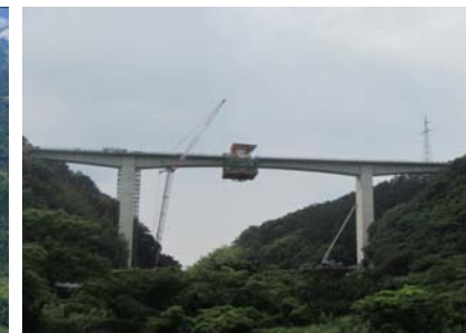
【国道9号から折居川橋を望む】 ○折居川橋PC上部工事 施工中
