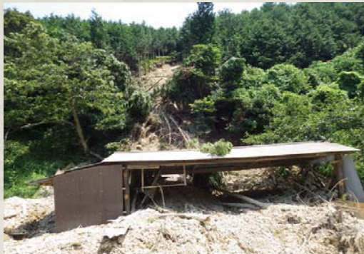
市道での北側斜面の小規模な崩壊
