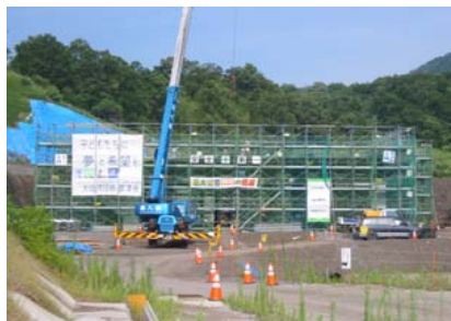
【熱田IC橋 北側から望む】 ○熱田IC橋工事 施工中
