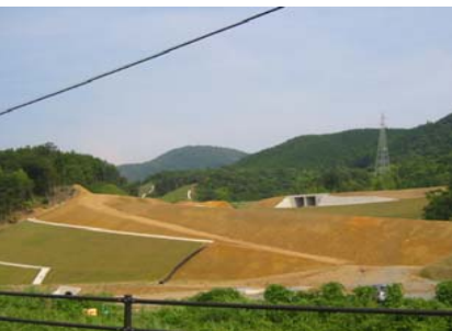
【西村IC(仮称)付近 整備状況(国道9号より望む)】
