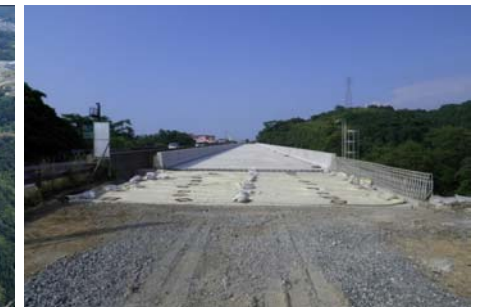
【みなと原井大橋を終点側から望む】 ○原井地区舗装工事 施工中
