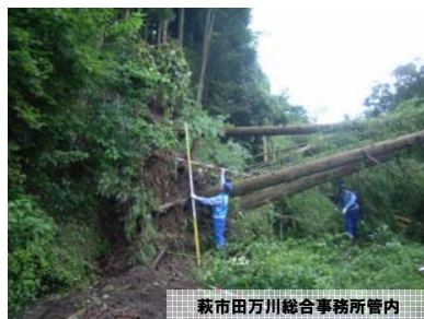
被害状況の調査を行う道路班
