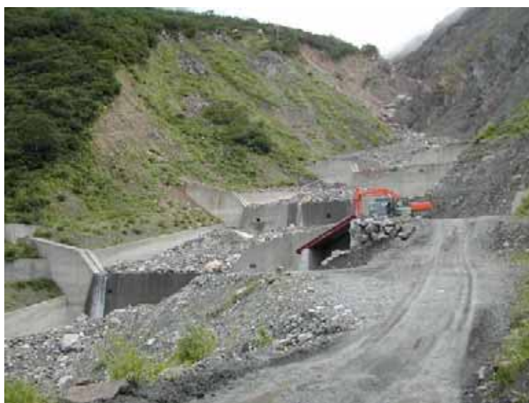
図 1.10 別当谷砂防工事の様子
