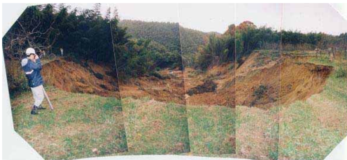
図-15 金沢市山科町で発生した流動性地すべり (2002 年 11 月 8 日発生) (石川県県央農林総合事務所 提供)
