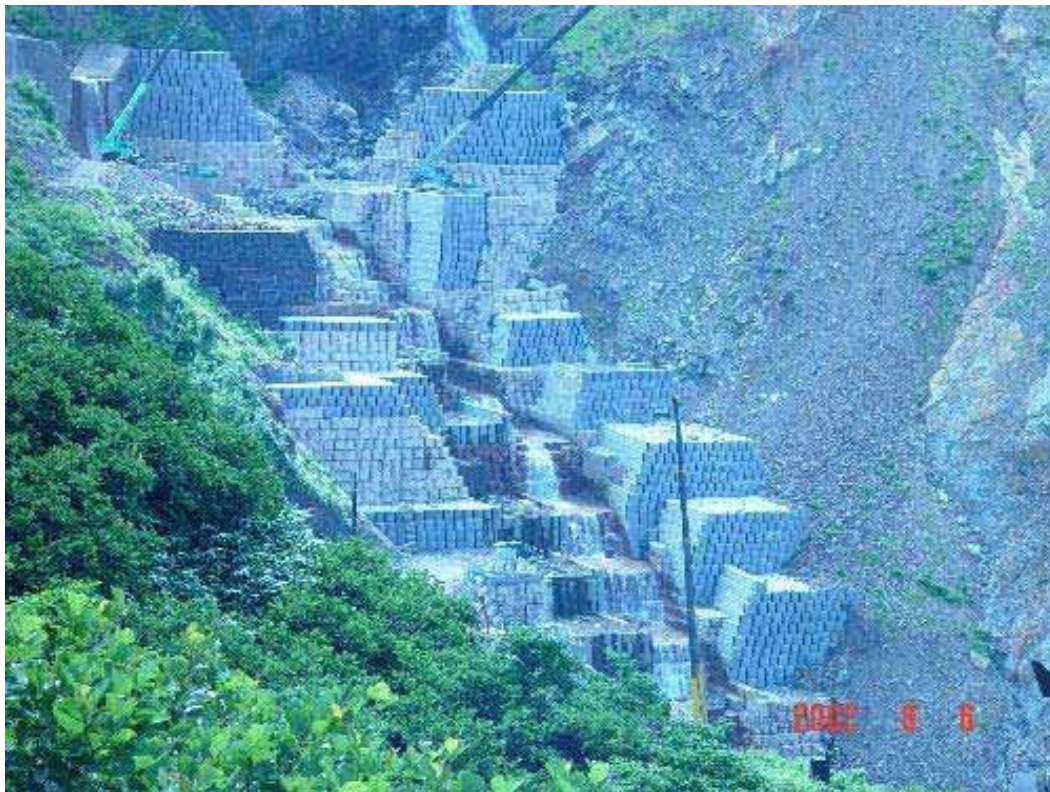
図 2.3 甚之助谷側の砂防堰堤群（2002年8月6日撮影）
