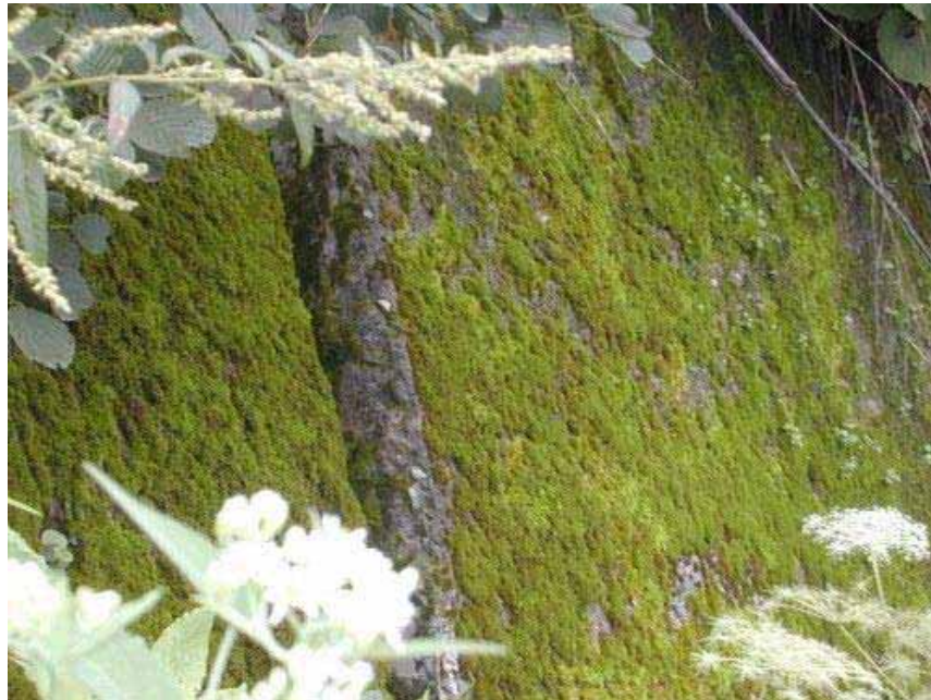
図 3.5 甚之助谷側が突出しているコンクリート擁壁 (2003 年 9 月 29 日撮影)
