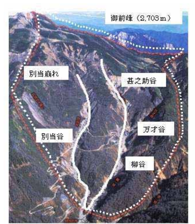
図-20 白山地域における別当崩れと甚之助谷地すべり
