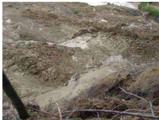
内部の崩落土塊は飽和状態でヘドロ化している
