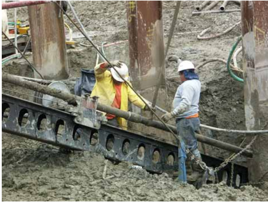
図 18 留めアンカー - 抑制杭システムの設置風景（アンカー貫入）
