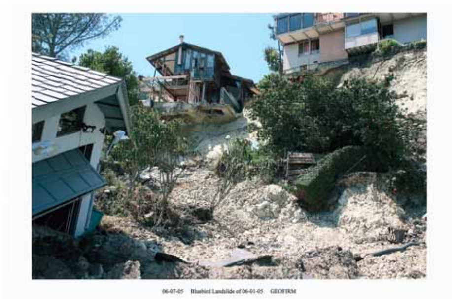
図 12 Bluebird Canyon 地すべり頭部での崩壊状況 (GeoFirm2005年6月7日撮影)
