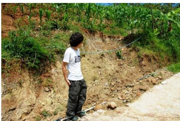
**写真 11**：一つ目の地すべりポイント道路脇で見られた小規模な崩壊（汪先生撮影）
